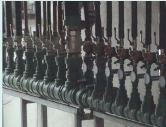
ΕΦΑΡΜΟΓΕΣ ΙΣΟΣΤΑΘΜΙΣΗΣ ΥΔΡΑΥΛΙΚΩΝ ΔΙΚΤΥΩΝ
